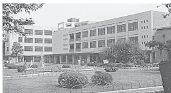
文理学部校舎 中庭と旧2号館・3号館
